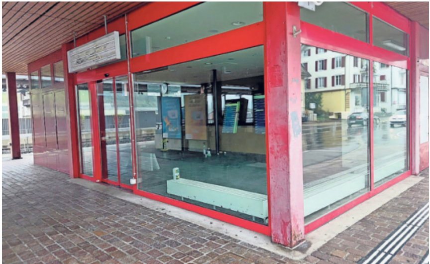
Das Gebäude am Bahnhof Schwyz stammt aus den 1980er-Jahren. Derzeit laufen letzte Umbauarbeiten. Bild: Valentin Köpfli
